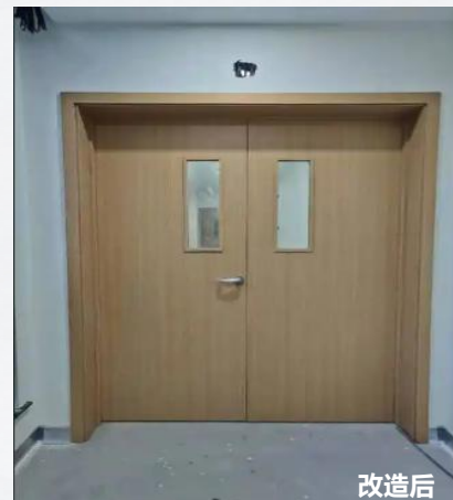
更换防火门，保障耐火防烟性能
